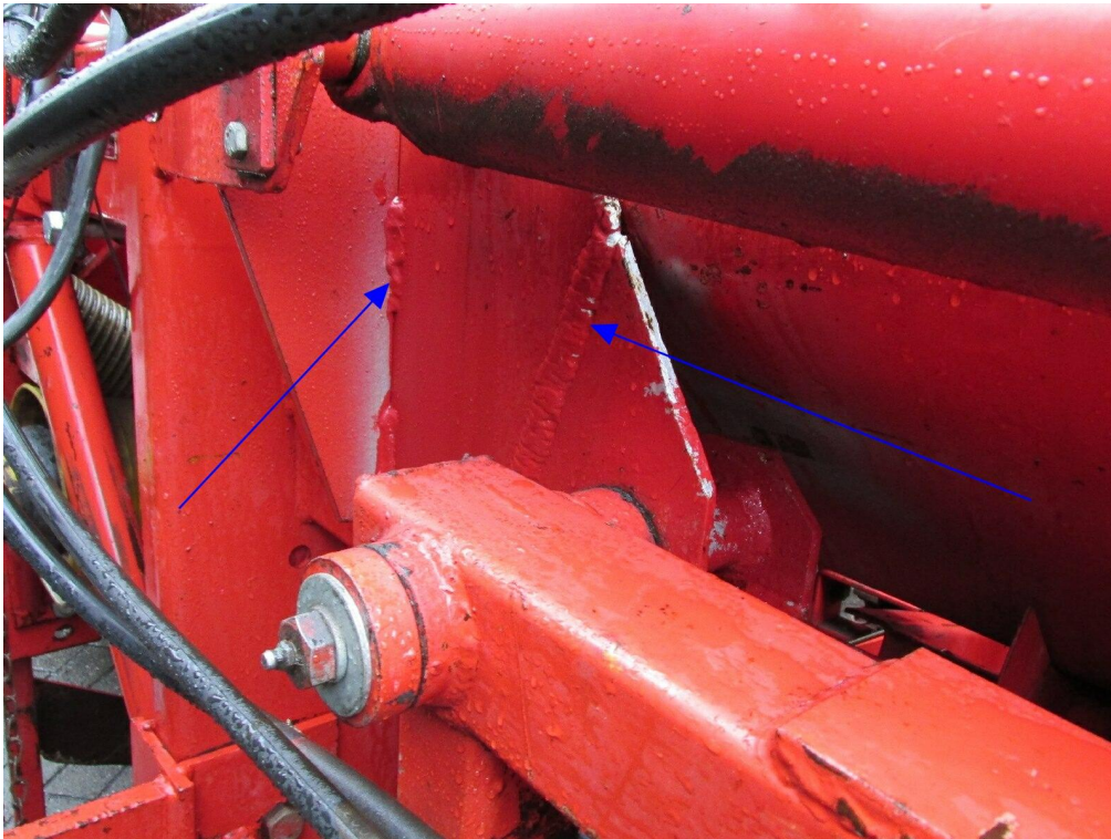
Bild 15: Reparaturschweißung am Grundrahmen
